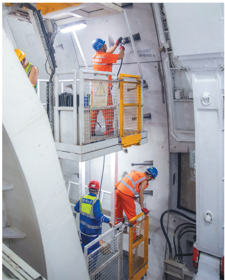
10月21日,建设者正在江阴靖江长江隧道右线隧道“匠心一号”盾构机内部作业。这座中国在建最大直径过江隧道正以每天16米的速度稳步推进。 赵李善 摄
