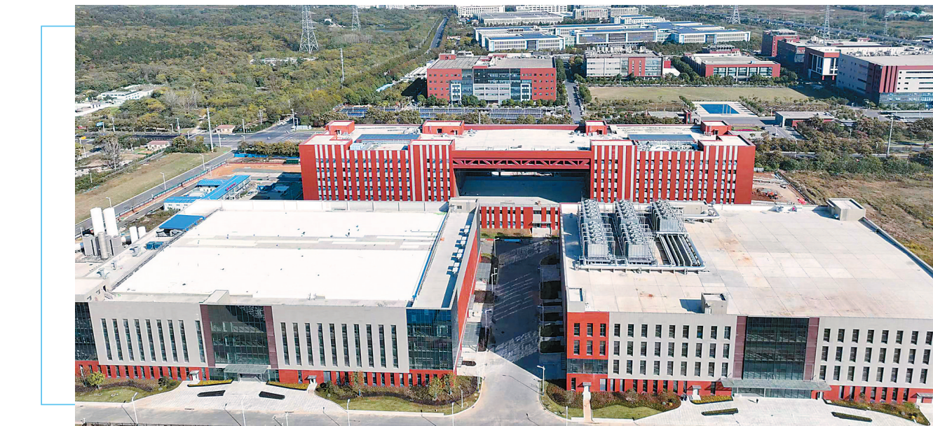
由中铁建工建设的国博射频的项目位于南京市江宁区,预计于年底交付。项目建成后主要面向新一代基础设施建设,布局射频集成电路设计、制造、封测等全产业链关键环节,建设化合物半导体制造线,将形成年产化合物半导体圆片6万片、射频集成电路5亿只、射频模块1000万只的设计制造能力,产品供应5G及未来移动通信基站和终端市场。图为该项目10月25日的航拍图。通讯员 杨咏 本报记者 邵丹 摄
