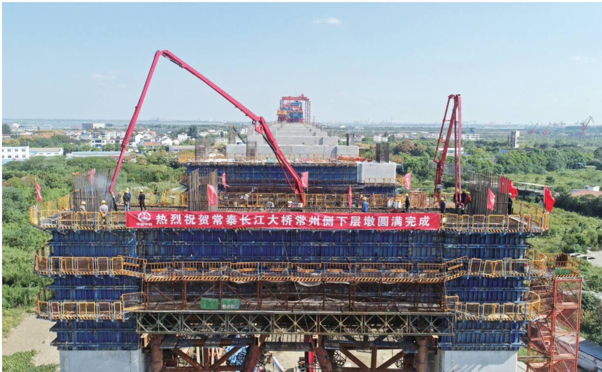
常泰长江大桥常州侧全面进入上部结构施工
