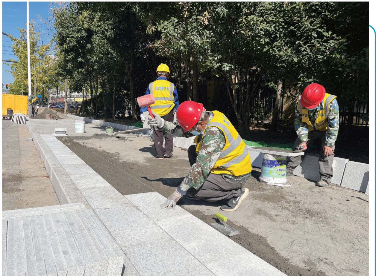
因历史遗留原因,南京浦口主城区部分边角地块因无人管养,出现市政设施破损、绿化缺失,影响市民出行,也拉低了城市“颜值”。浦口城管兴浦市政公司秉持“到边到角”的养护理念,在上级部门指导下,会同园林公司针对主城区边角设施进行“微改造”,全力刷新城市“颜值”。图为10月29日,工人在对人行道周边破损进行整治。
