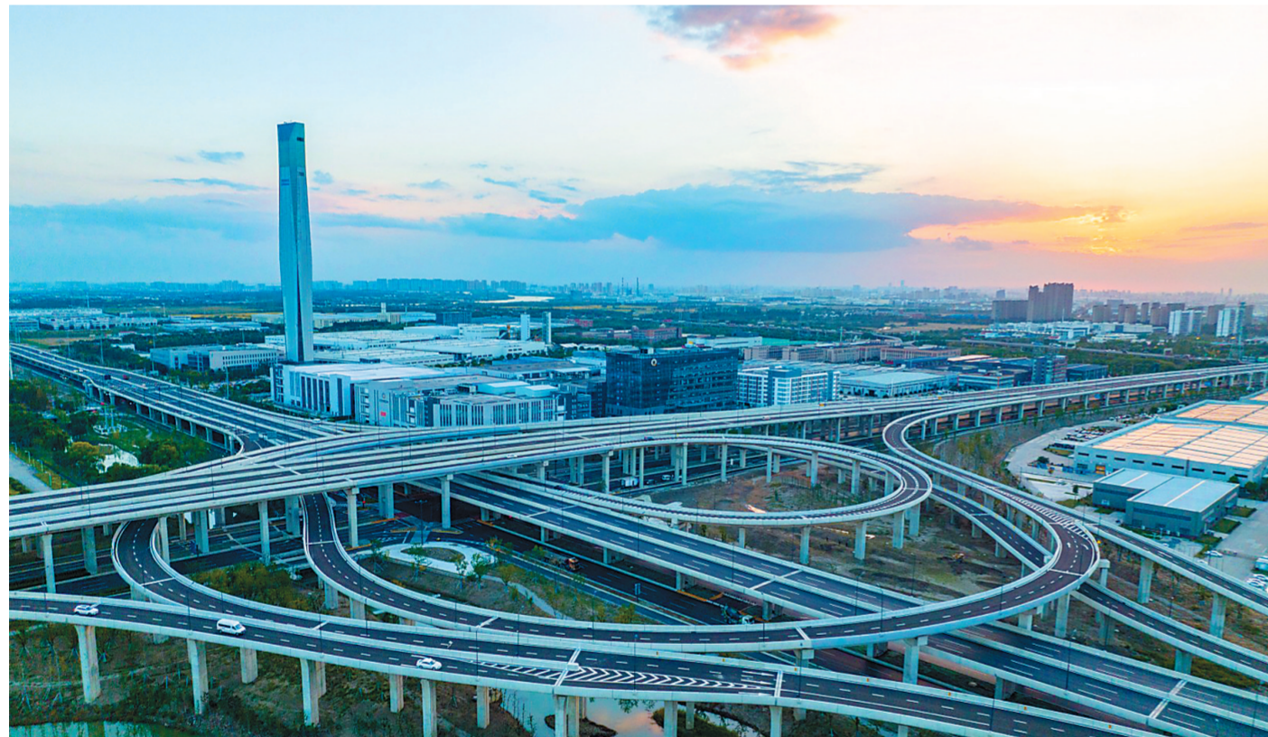
10月31日,312国道苏州东段改扩建工程(苏昆中环互通)实现通车,苏州市区到昆山最快全程15分钟可达。该工程是江苏省重点工程、苏州地区重要的东西向干线公路。 袁新宇 摄 (视觉江苏网供图)
