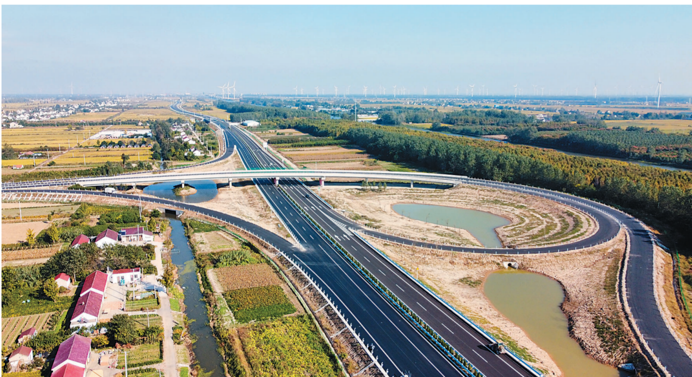
16日,由中铁五局承建的国家重点工程盐射高速公路沥青路面工程全线铺通。路线主线全长约22.5公里,总投资约24.5亿元,拟采用双向四车道高速公路标准,设计时速120公里。 谢永彬 谢文卿 摄
