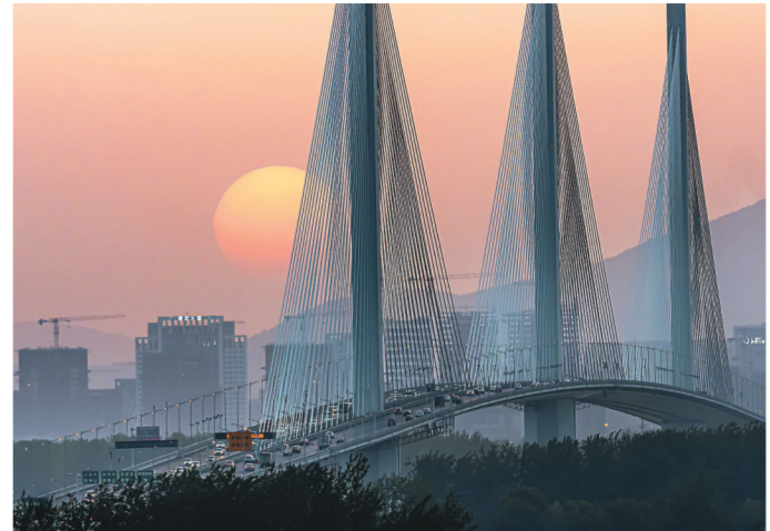
繁忙的南京江心洲大桥。该桥是世界首座轻量化全钢-混组合结构斜拉桥,大幅降低混凝土用量和人工投入。陆春南摄
