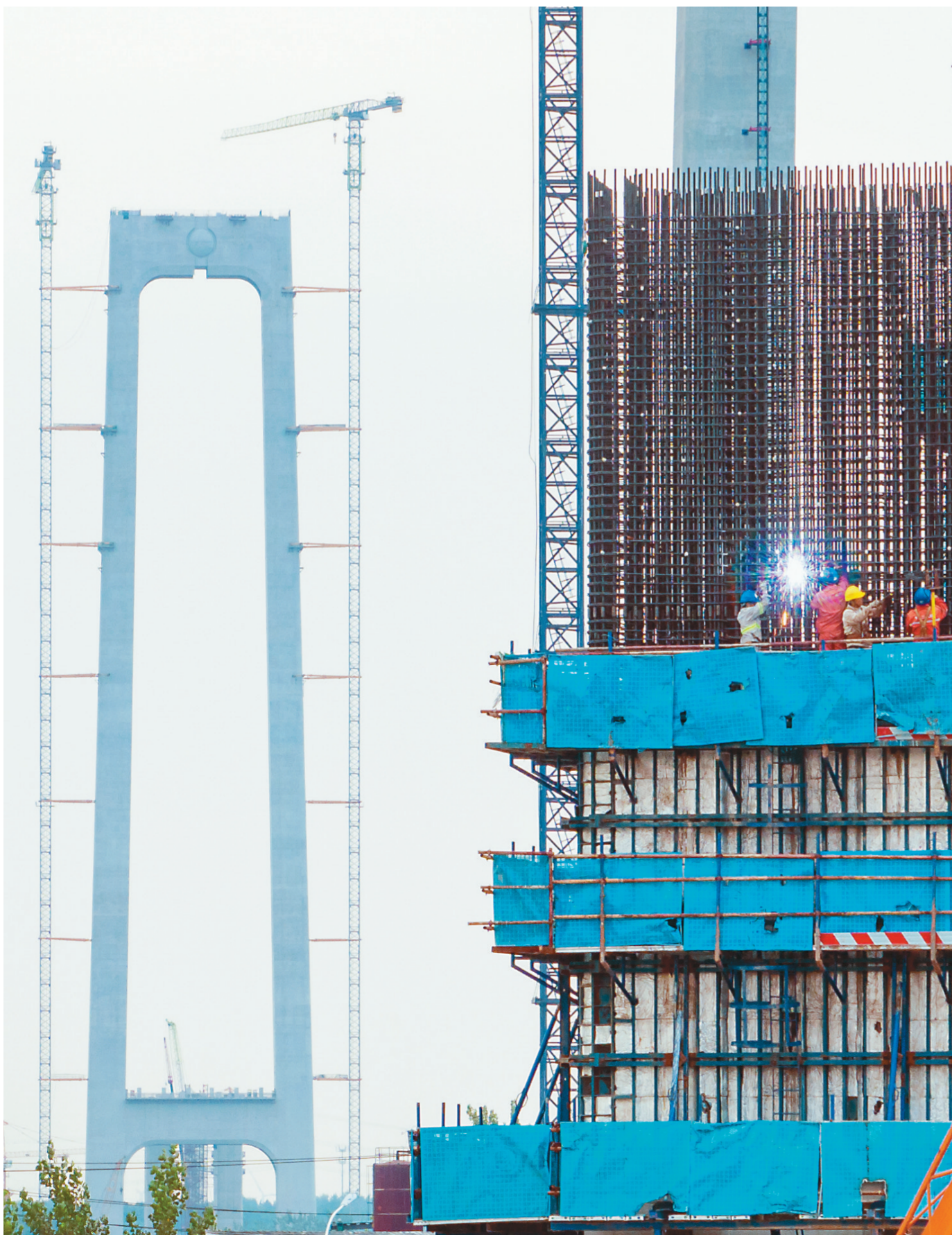
预计二〇二四年建成通车的龙潭长江大桥,是南京过江通道中最东边的一条公路过江通道,是宁镇扬一体化的重要交通设施。张勇摄
