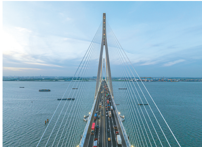
车水马龙的苏通大桥。吴天威摄
