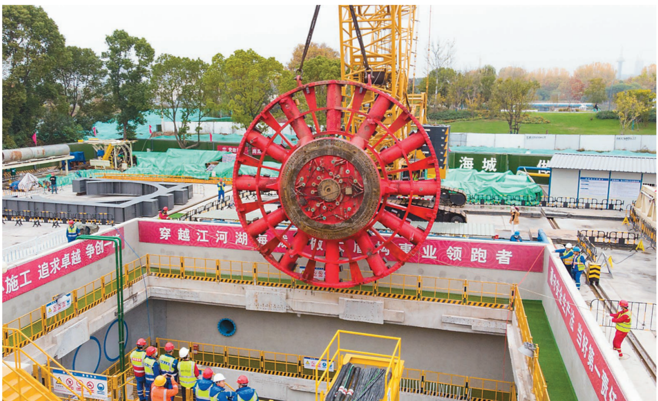
20日,随着中铁十四局建设者将重127吨、直径9.15米、配备314把刀具的盾构机刀盘顺利下井组装,南京重点市政工程——江心洲污水收集系统二通道穿越夹江段项目整台盾构机完成组装,转入调试阶段,预计12月初始发掘掘。 通讯员 王艳 本报记者 邵丹 摄
