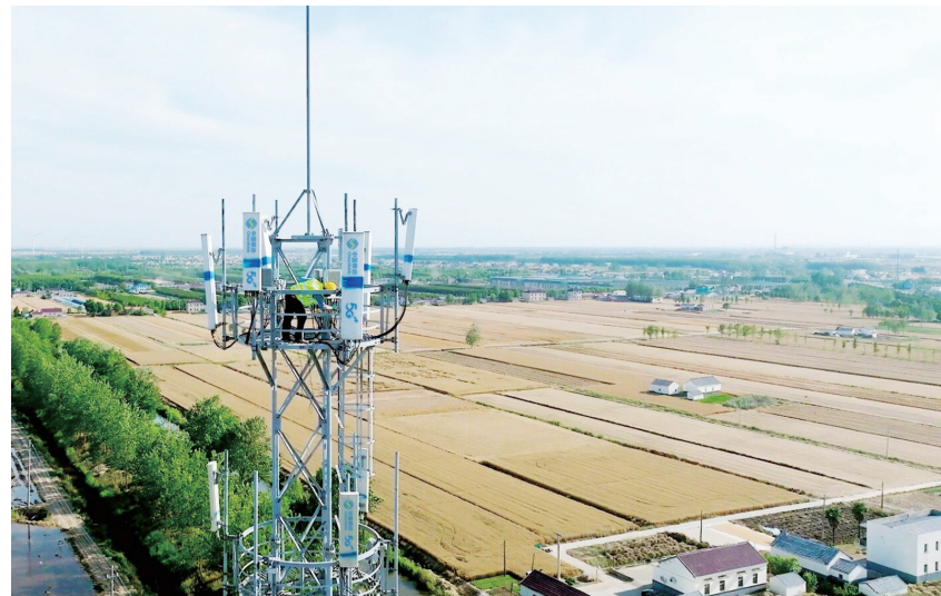
移动网络技术人员在盐城市盐东镇坞港村建设5G基站
