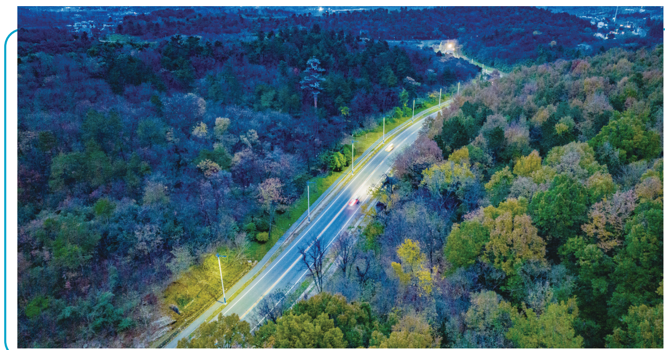
秋冬入夜早且快,南京老山深处的山村公路能做到紧跟日落时间,灵活调控路灯照明,保障市民平安出行。作为2022年重点民生工程,浦口区对总长40.9公里,5条干线公路的2300余盏路灯进行了硬件翻新,并统一接入浦口区智慧路灯平台系统,可远程后台调控路灯关灯时间,路灯故障自动报警,更好地保障市民通行安全。图为12月2日17点左右,岔路口的路灯及时打开,照亮市民回家路。于瑞华 摄
