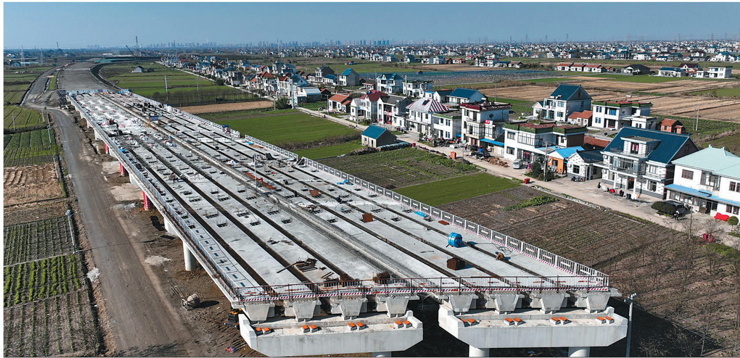
图为6日拍摄的南通洋通高速二期工程四岔公路大桥架梁施工现场。架桥工人正抓住当前晴好天气推进施工,确保工程按期完成。洋口港至南通高速公路洋口港至如东城区段工程全长约16公里,项目建成后,使洋口港快速接入G15、G40等国家干线高速,南通市区可高速直达洋口港。
