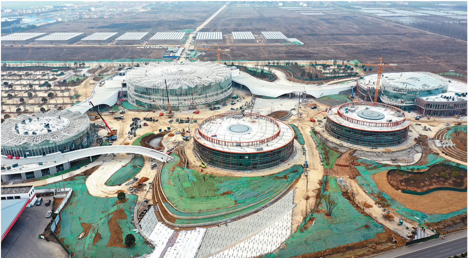
沐阳县华东花木大世界建设工程被列入2022年江苏省重大项目清单,总建筑面积13万平方米,计划投资约30亿元。建成后,将集花卉盆景园、博物馆、会展中心、电商中心、物流园等功能于一体。图为15日,该工程施工人员在忙着进行屋顶构架安装。丁华明 摄(视觉江苏网供图)
