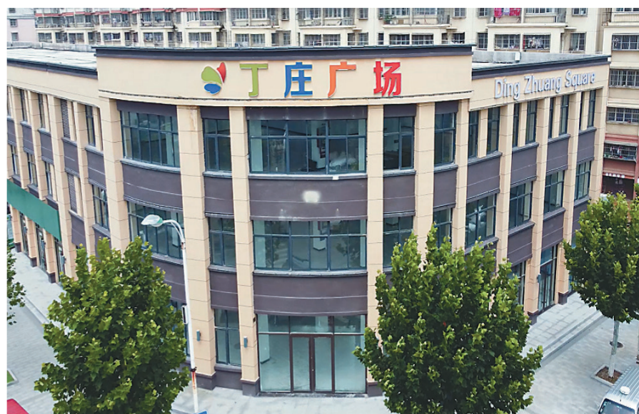
丁庄广场建设中
