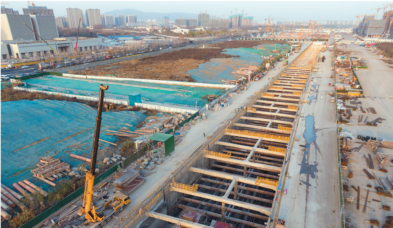
昨日,中铁十五局的工人在南京地铁10号线二期工程机场跑道旧址进行主体施工,目前该车站主体施工已完成97%,二期工程全线建成后将为南京市民提供出行便利。
