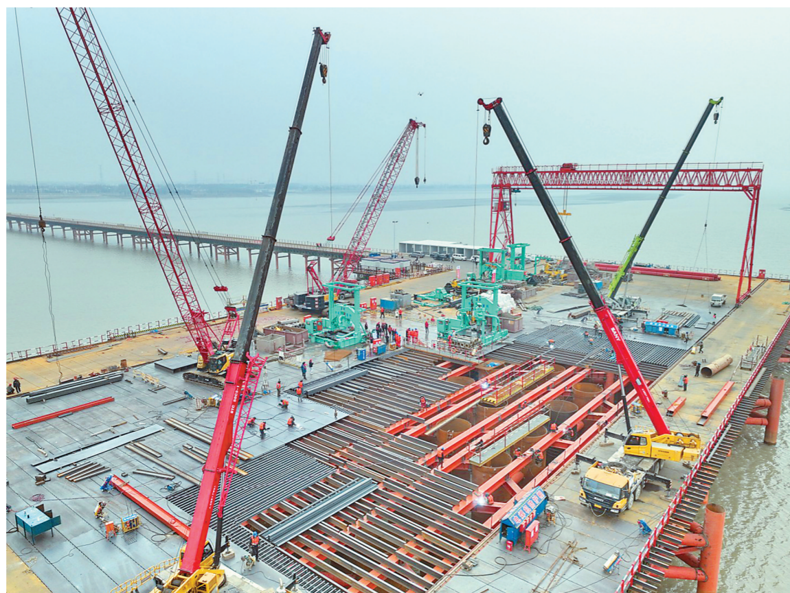
昨日,由中交二航局施工的张靖皋长江大桥水上主塔首根桩孔顺利开钻。张靖皋长江大桥南航道桥主塔高350米,建成后将是世界最高悬索桥主塔。图为昨日拍摄的张靖皋长江大桥水上主塔首根桩孔施工现场。图由中交二航局提供。许从军 摄(视觉江苏网供图)
