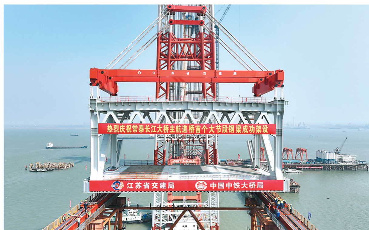
大节段钢梁位于常州市永安洲一侧。 昨日，由中铁大桥局承建的常泰长江大桥主航道桥首个大节段钢梁吊装完成，标志着主航道桥钢梁架设全面展开。本次吊装的主航道桥钢梁由张子熠、丁胜杰、文陈昭摄。
