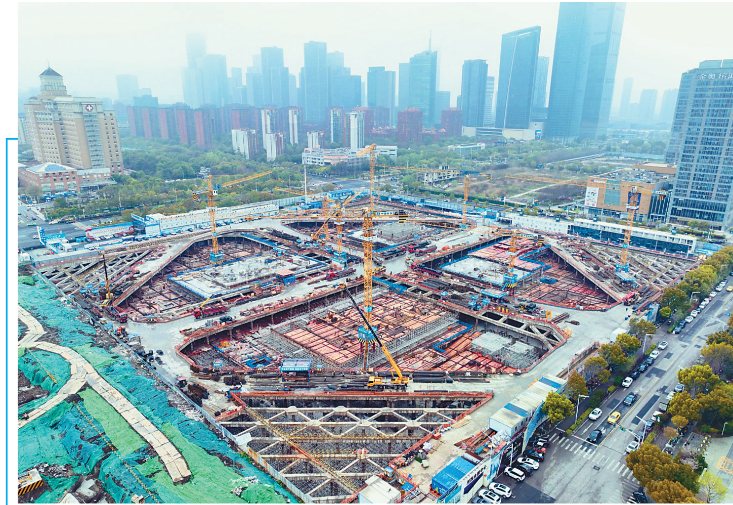
南京河西金融中心位于河西核心区域,规划用地面积约10.3万平方米,投资规模101.6亿元,是推动南京金融服务业转型升级的重点项目。图为21日,河西金融中心建设现场。
