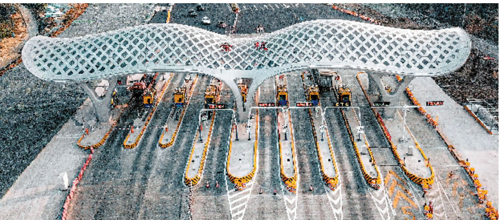
8月2日,杭徽高速余杭互通全新的收费大棚正式亮相。它采用钢结构镂空形式,造型如大鹏展翅。项目整体建成后,可以有效缓解余杭互通拥堵状况,实现高速公路与快速路之间的快速交通转换。
