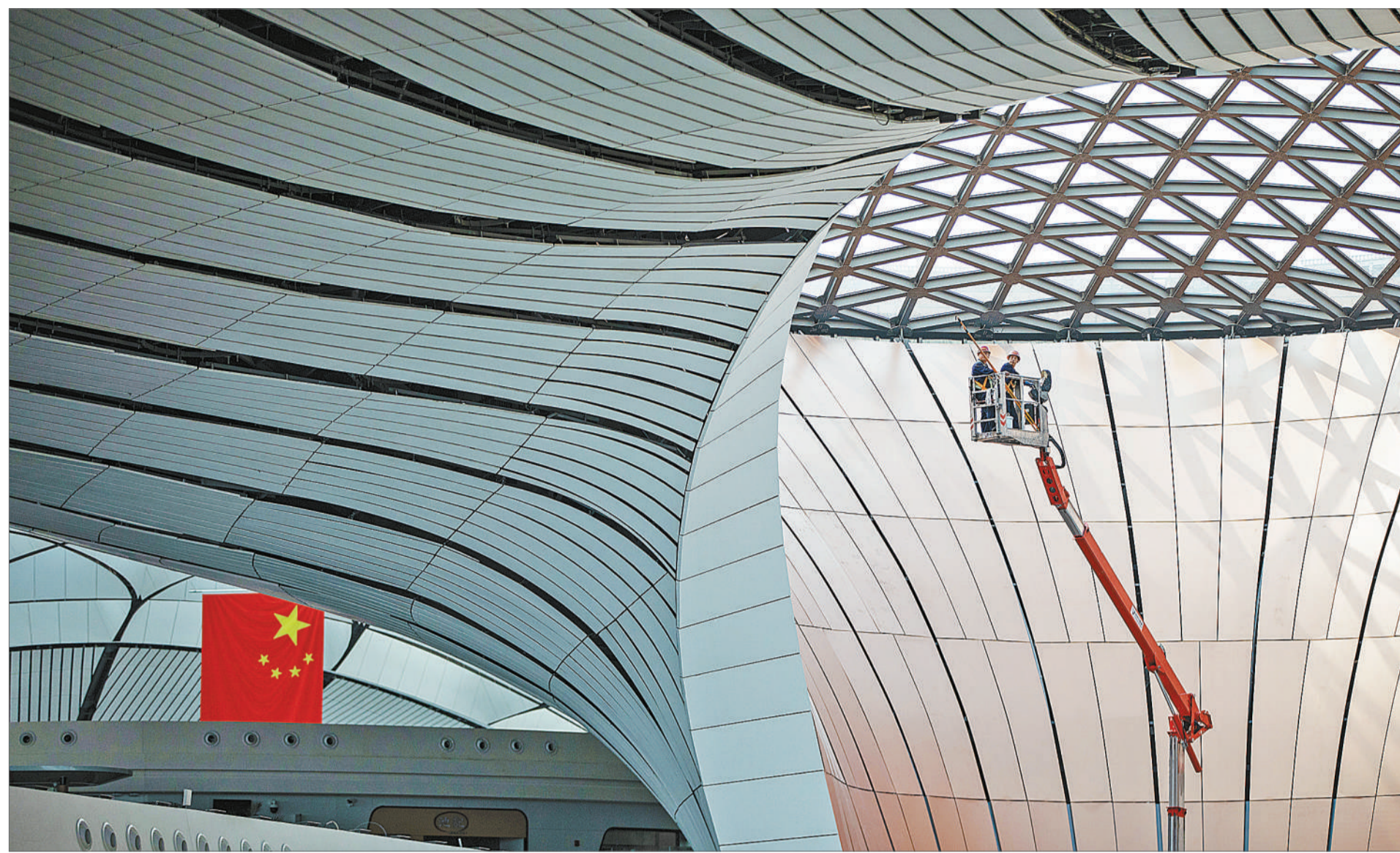
2019年9月4日,北京大兴国际机场,工作人员在室内装修完成后进行保洁工作。
