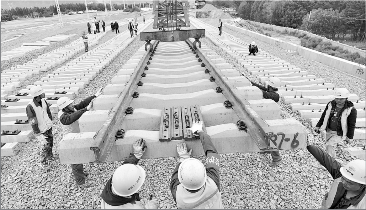
9月2日,工人在山南市泽当车站进行铺轨作业。当日,由中铁十一局承建的川藏铁路拉萨至林芝段铺轨到达山南市泽当车站。泽当车站的通航意味着从拉萨至山南已经满足了基础的施工行车需求。 新华社记者 觉果 摄
