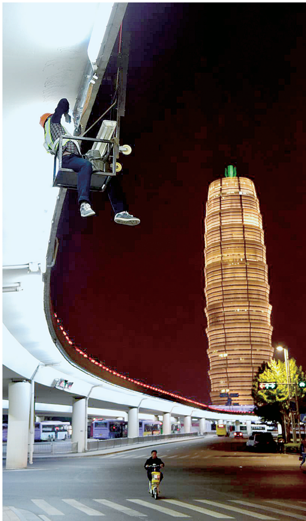
城市管理部门维修立交桥灯饰
