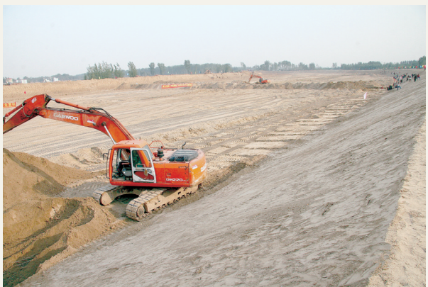
2007年,东风渠沉沙池正在建设中
