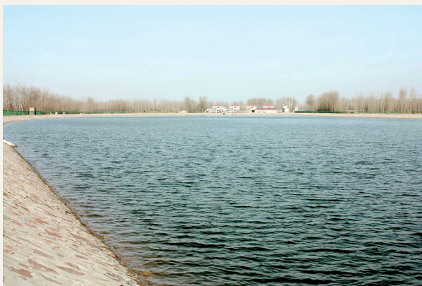
东风渠沉沙池蓄水后
