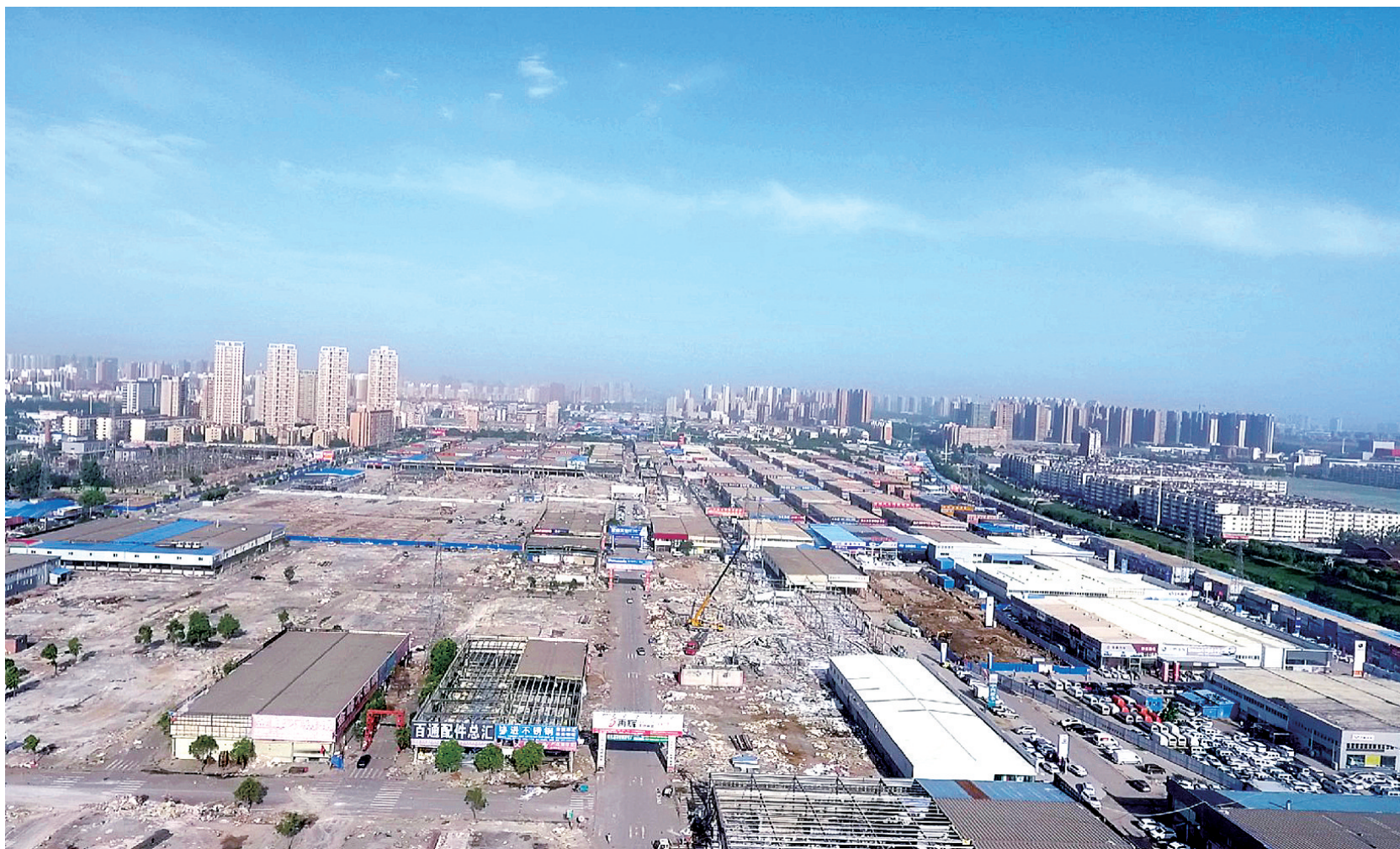
自贸区建设现场
