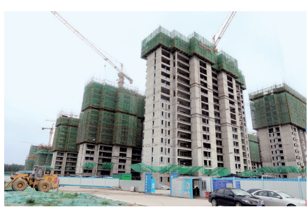
杓袁村安置房建设工地
