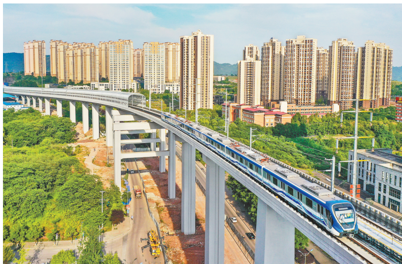
重庆加快建设“轨道上的都市区”,一批融城通道及轨道交通建设项目加速实施。这是即将通车的江跳线在进行不载客试运行。(摄于5月5日)
