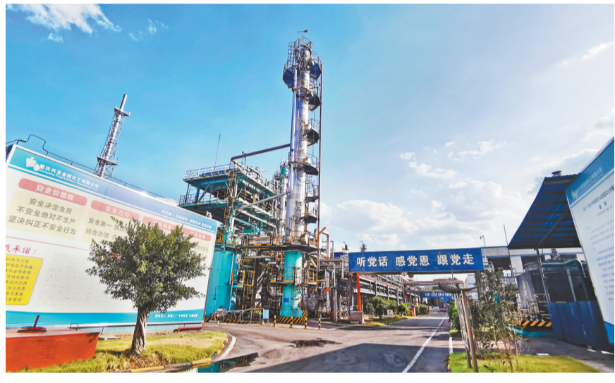
兴发金冠厂区一角。
