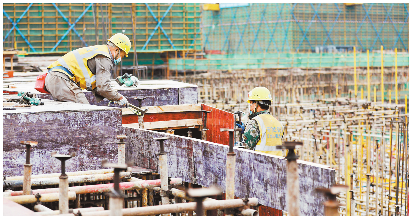
十一月十四日，西部（重庆）科学城科创示范项目一期工程，工人在加紧施工。首席记者 龙帆 摄/视觉重庆
