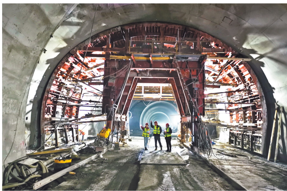
渝湘复线高速彭酉段摩围山隧道里,施工人员正在作业。 首席记者 陈维灯 摄/视觉重庆
