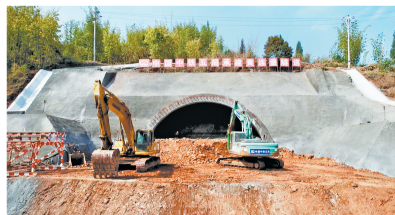
3月30日，在成渝中线高铁首座隧道——黄连堡隧道施工现场，工程机械在进行现场作业。（受访单位供图）
