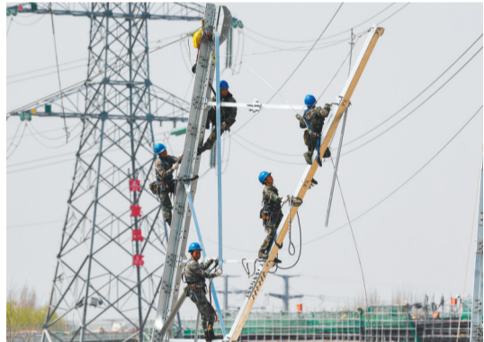
电力工人正在开展新输电杆塔的组建、安装工作。
