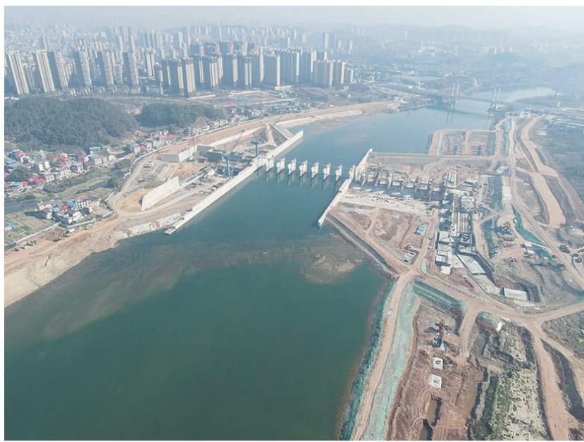
犬木塘水库枢纽工程。 通讯员 摄
