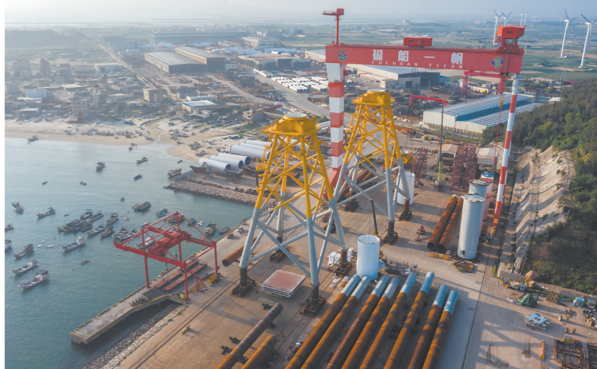
28日,在漳浦县福建福船一帆新能源装备制造有限公司码头,两套垂直高约65.52米、重1635吨的海上风电导管架已完成建造,将于近期出海运往漳浦六整海上风电场二期项目海域。该项目计划于今年8月底完成首批机组并网发电,全部投产后天上网电量超过16亿千瓦时。 本报记者 王毅 通讯员 陈启民 查自强 摄
