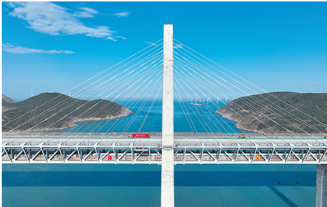
近日,福州工务段工人在高空对平潭海峡公铁大桥斜拉索进行作业(无人机照片)。
