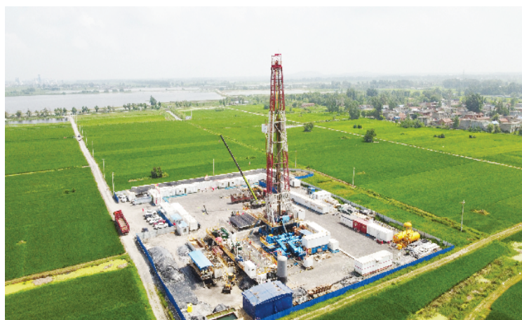
淮河能源控股集团煤业公司潘二地面瓦斯治理井。
