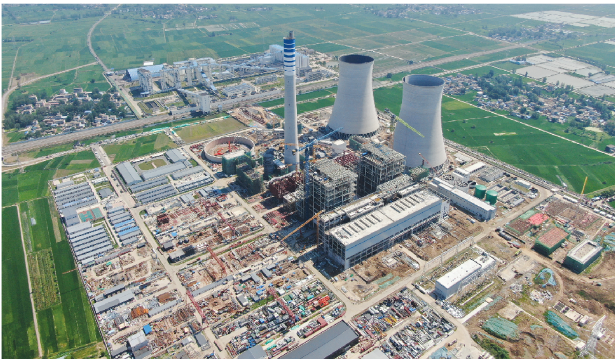
正在建设中的潘集电厂。
