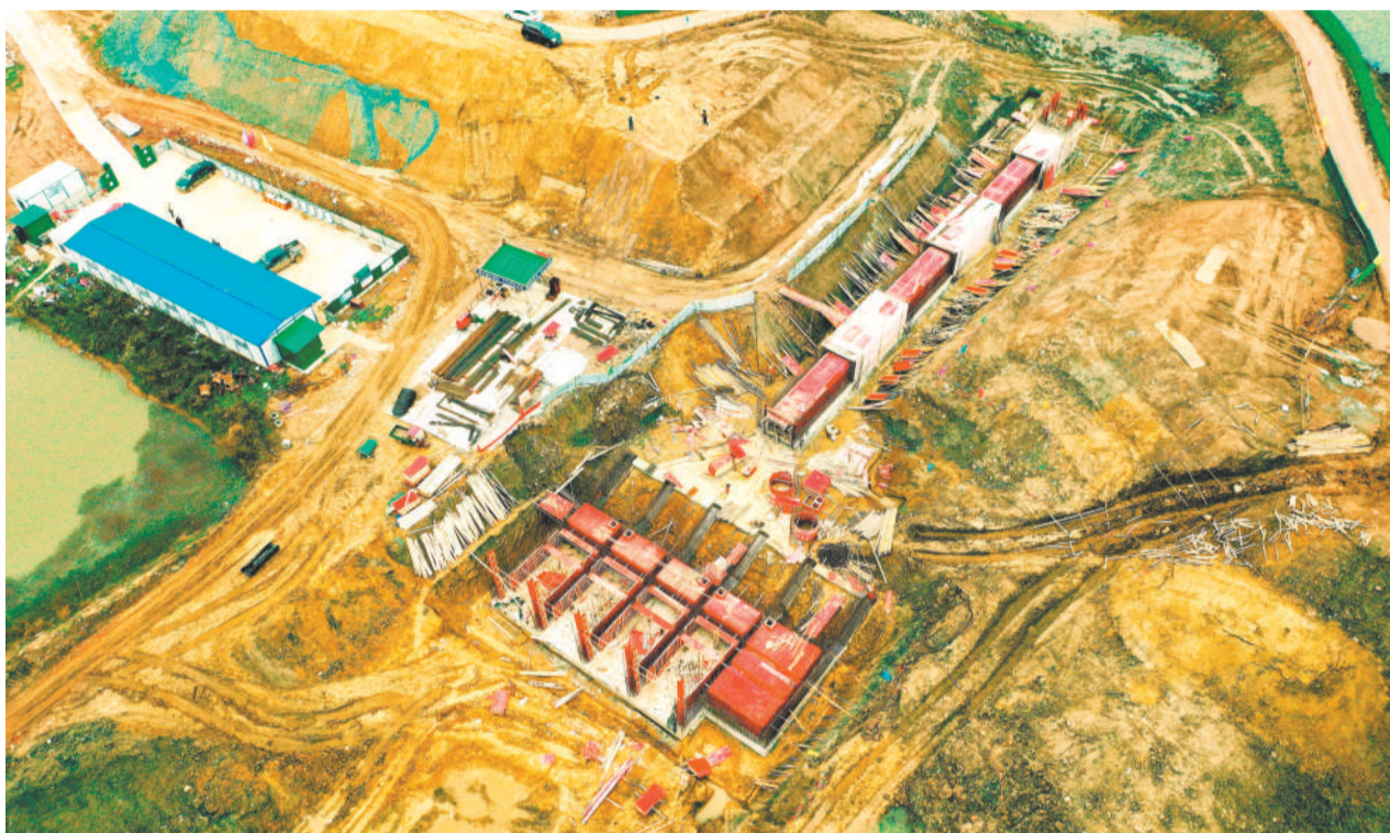
连日来,马鞍山市博望区重点水利工程正加快建设,以保障该区24万亩粮食稳产及石臼湖防汛排涝。图为丹阳湖农场二号泵站拆除重建工程现场。 本报通讯员 陈亚东 刘静 摄
