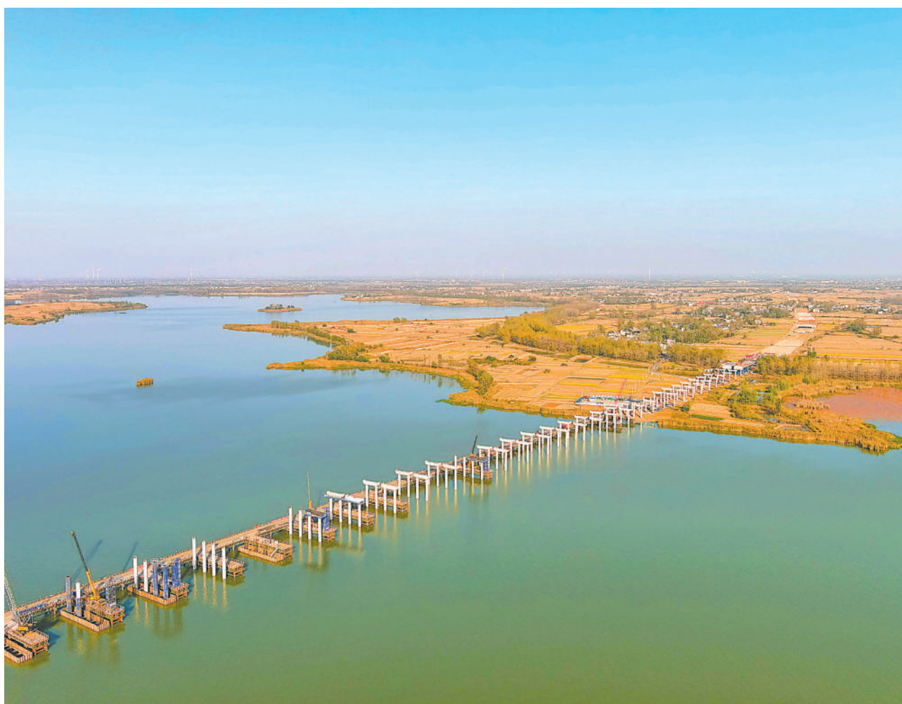
10月29日，五河至蒙城高速公路沱湖特大桥施工现场，钢箱梁焊接作业正紧张有序进行。五蒙高速是联通豫皖苏的重要省际通道，建成后将在完善皖北高速路网、推动区域经济发展等方面发挥重要作用。
