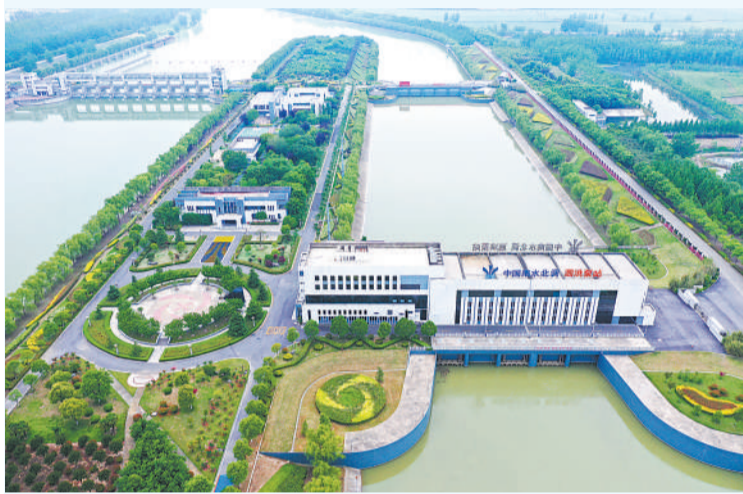
这是位于江苏省泗洪县的南水北调东线一期工程泗洪站枢纽。(资料图片) 新华社发(方东旭 摄)
