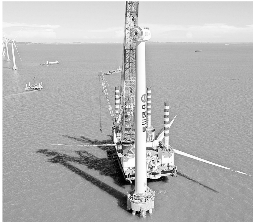
福建福清兴化湾二期海上风电场吊装10兆瓦海上风电机组(6月12日摄,无人机照片)。记者7月13日从三峡集团了解到,国内首台10兆瓦海上风电机组日前在三峡集团福建福清兴化湾二期海上风电场成功并网发电,这是目前我国自主研发的单机容量亚太地区最大、全球第二大的海上风电机组,刷新了我国海上风电单机容量新纪录。新华社记者 林善传 摄
