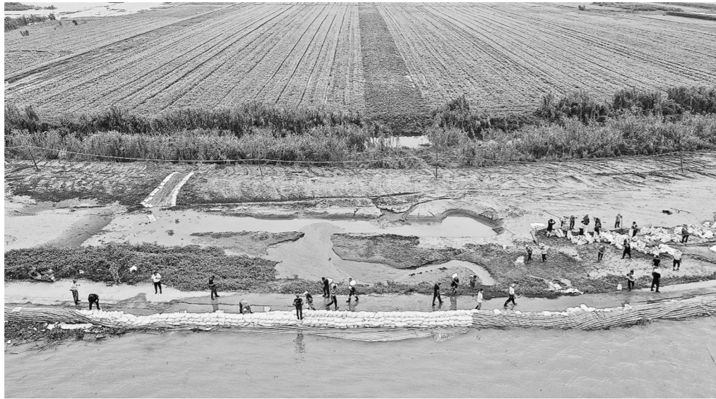
在江西省九江市柴桑区江新洲的防洪大堤上，防汛人员在搬运沙袋，加固堤坝，他们中大部分是主动返乡参与防汛人员。 新华社记者 彭昭之 摄
