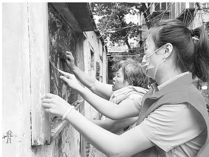
车长摇身变“楼长” 助力小区换新颜
